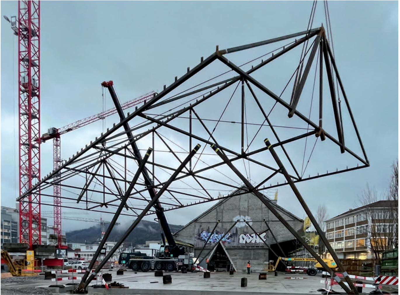
Der Dachstuhl der Schwarzstahlhalle wird auf die vier Stützen gehoben.
