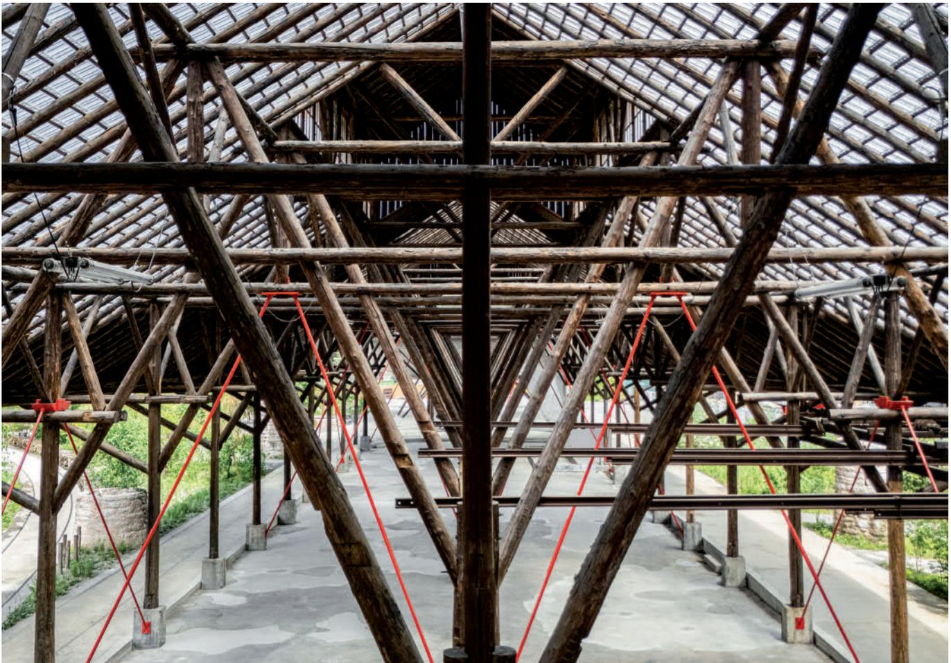
Getragen wird das Dach von einer kühnen Rundholzkonstruktion.
