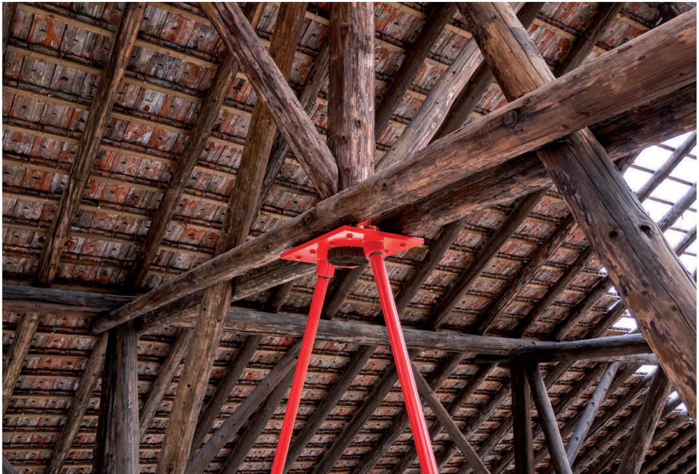
Rot markierte Zugstangen sichern die bestehende Rundholzhalle.
