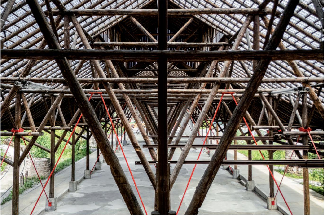
Getragen wird das Dach von einer kühnen Rundholzkonstruktion.
